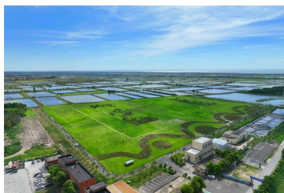
图 4 垃圾填埋场生态修复后
