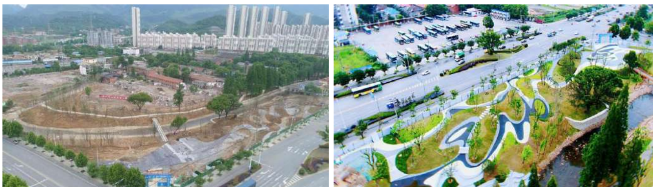
图4 两河（十里河、濂溪河）流域综合整治工程龙门公园建设前后对比图
