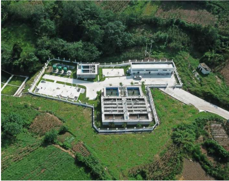
东兴区郭北镇污水处理场站，处理规模：1200 吨/天
