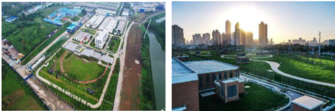
图 12 机场河 CSO 调蓄池及强化处理设施（左）、黄孝河 CSO 调蓄池（右）
