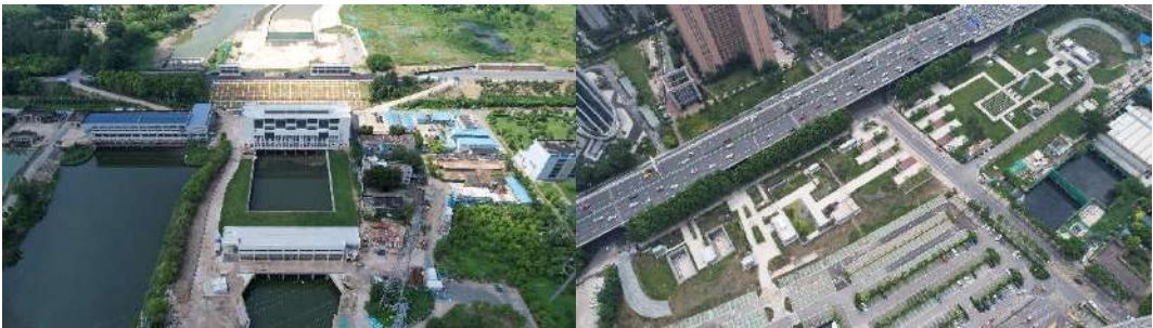
图 3 后湖二期排涝泵站（左）及铁路桥地下净化水厂（右）
