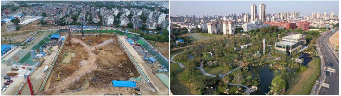
图 5 两河地下污水处理厂+双溪公园建设前后对比图
