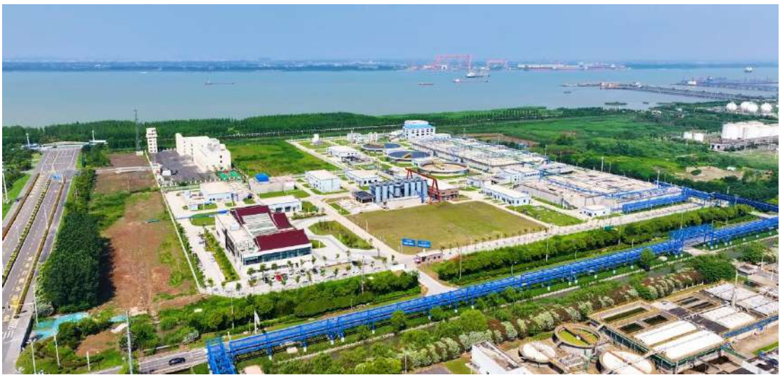
图 3 工业污水处理厂全景
