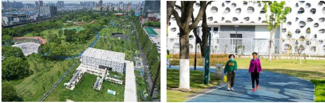
图 11 常青 CSO 调蓄池（左）、在常青 CSO 调蓄池上散步的居民（右）
