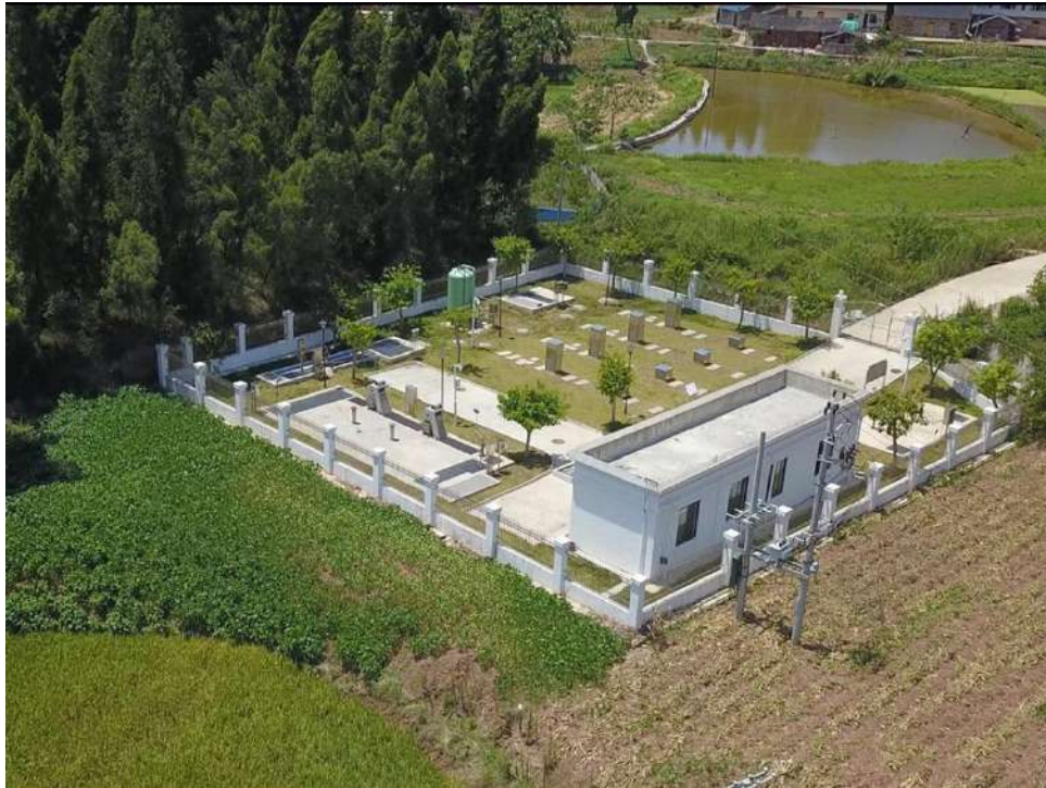
东兴区平坦镇污水处理场站 处理规模：300 吨/天
