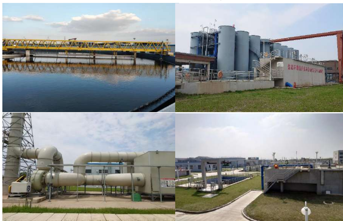
图 6 污水处理厂工艺设施实景
