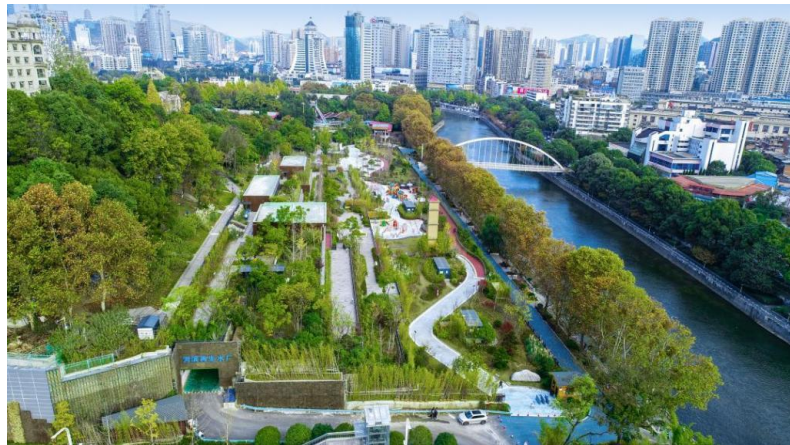
图 8 贵阳河滨下沉式再生水厂地面公园实景图
