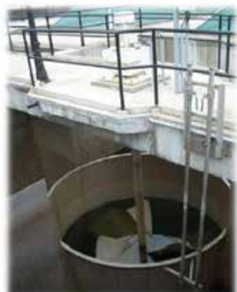
絮凝反应搅拌机 and 导流筒
