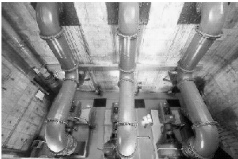
图 4-9 北京市左安门桥泵站
