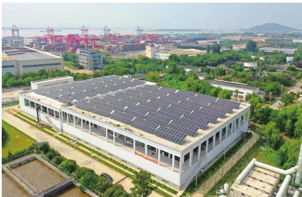
图 7-10 芜湖市朱家桥污水处理厂光伏发电项目
