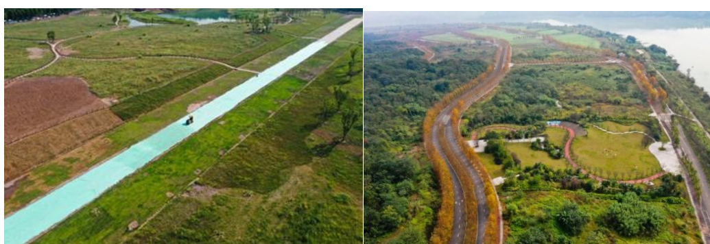
图 6-19 重庆广阳岛生态修复二期工程现场（左）和整体修复成效（右） [41]
