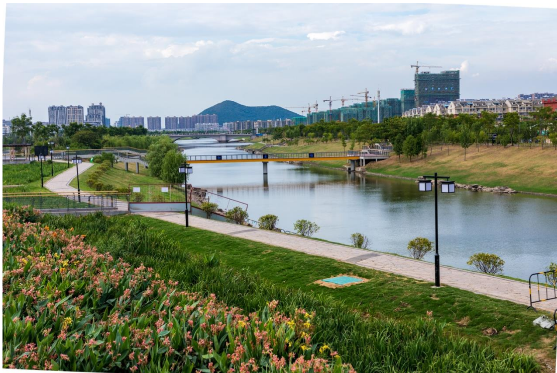
图 8-40 马鞍山市河道综合整治成效
