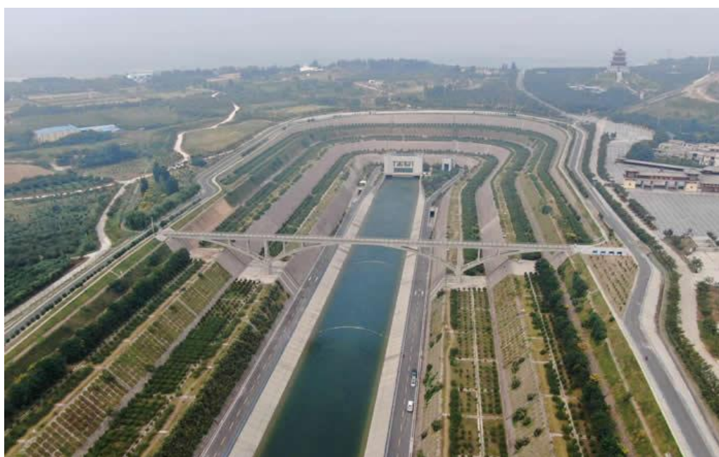
图 6-31 南水北调中线工程穿越黄河
