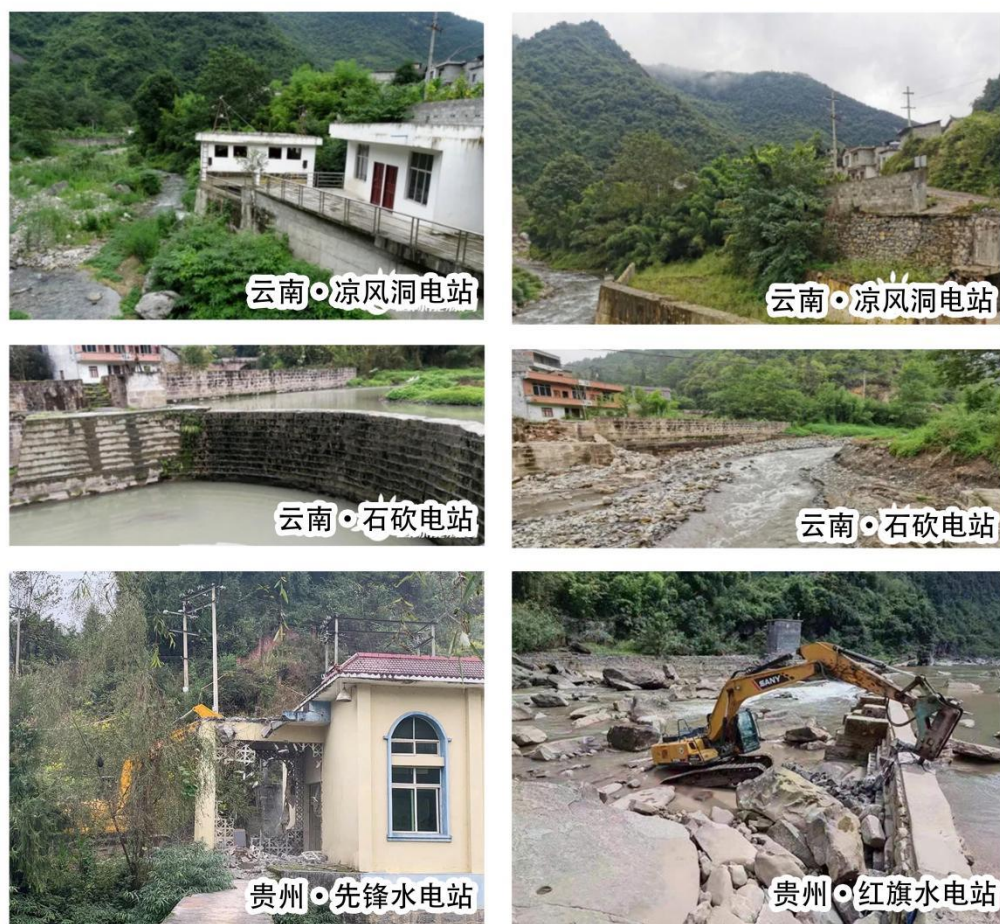
图 6-34 云南威信县凉风洞水电站厂房拆除前后；威信县石坎电站 1 号拦河坝拆除前后照片；2019 年 11 月贵州习水县先锋水电站拆除；2021 年 8 月习水县红旗电站拆除 [75]
