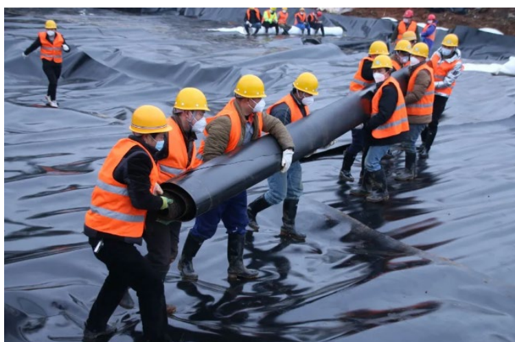
图 5-11 火神山医院施工人员在污水处理站下方铺设防渗膜
