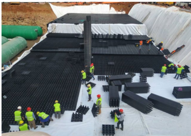
图 5-10 火神山医院雨水调节池现场模块组装图
