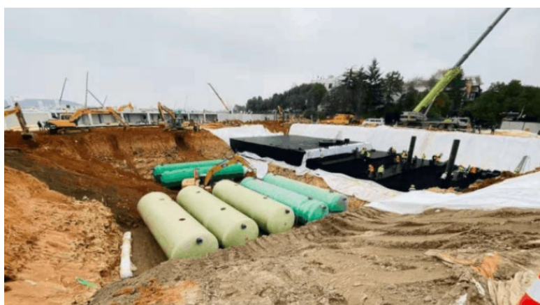
图 5-12 火神山医院化粪池现场施工图
