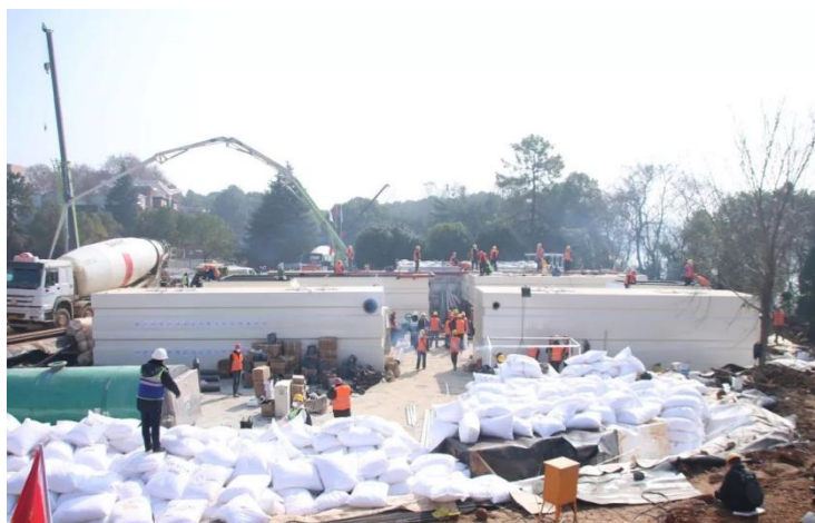
图 5-13 火神山医院预消毒池设计施工现场
