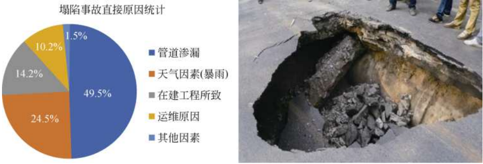
图 2-6 排水管道渗漏导致路面塌陷
