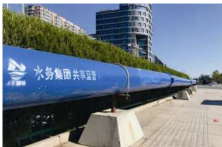
图 3-4 山东省临沂市为排放基坑降水设置的共享“小蓝管”
