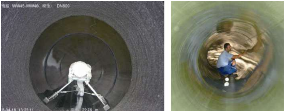
图 5-14 非开挖修复技术修复后排水管道
