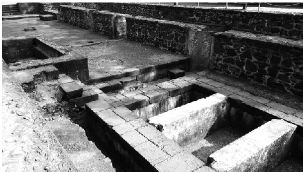
图 1-21 具有排水防御的下水道
