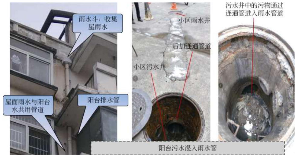
图 2-26 阳台水混接案例
