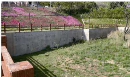
(b) 道路蓄水池工程
